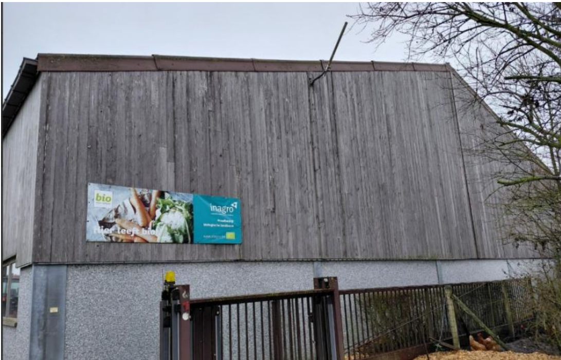
Afbeelding: kleine openingen in de spaceboarding van de loods zullen toegang geven tot de ruimte achter de planken waar vleermuizen rust en warmte zullen vinden
