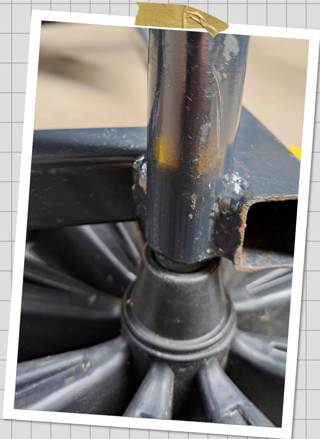
detail aanlassen W1
