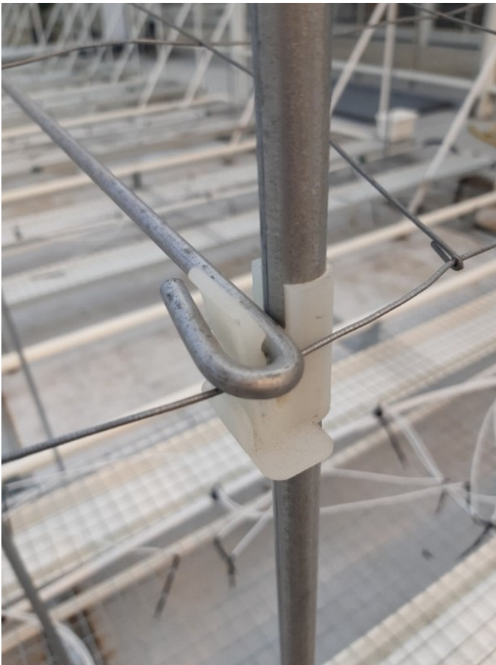
Foto 3: Gebruik van selfaklemmen om dwarsliggers op hun plaats te houden
