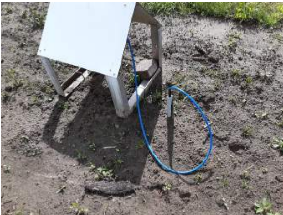
Foto 9: Bescherming werd aangebracht rond de kabel om verdere schade door wild te voorkomen
